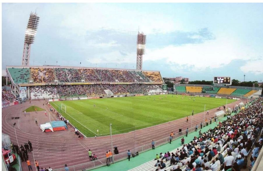
Рис. 6. – Краснодар. Главная арена стадиона ФК «Кубань». Современный вид [14]
