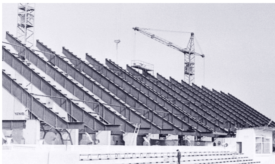
Рис. 5. – Краснодар. Стадион «Кубань», Надстройки верхних ярусов. После реконструкции максимальная вместимость стадиона поднялась до 50 тыс. человек. 1980 г. [13].
